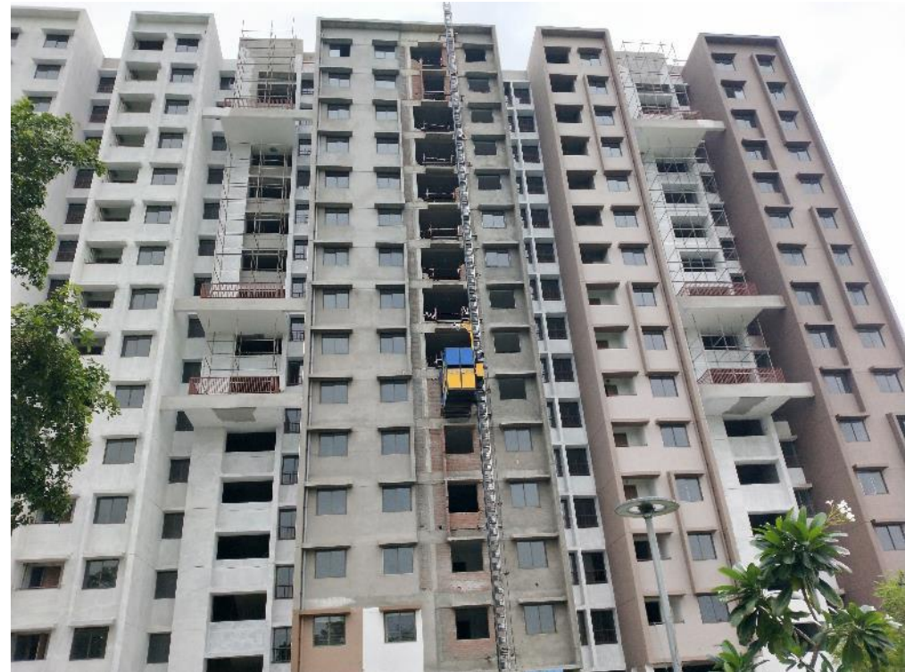
Actual Construction Images
