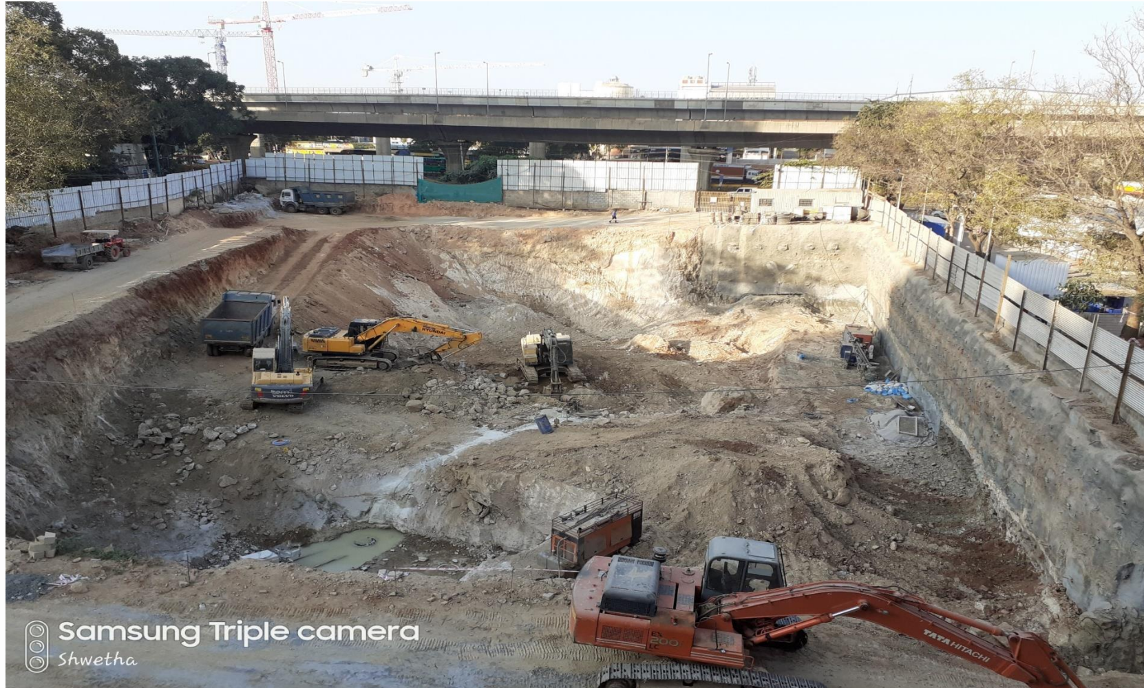
Actual Construction Image
