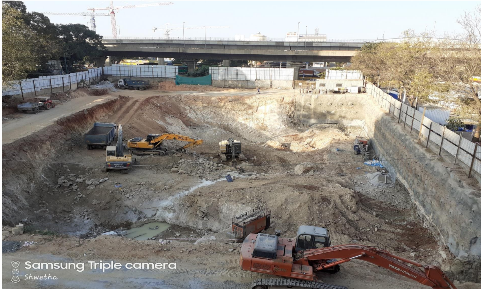
Actual Construction Image
