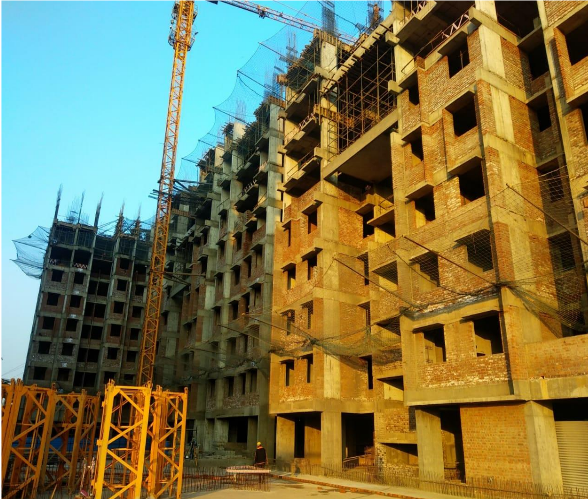
Actual Construction Image
