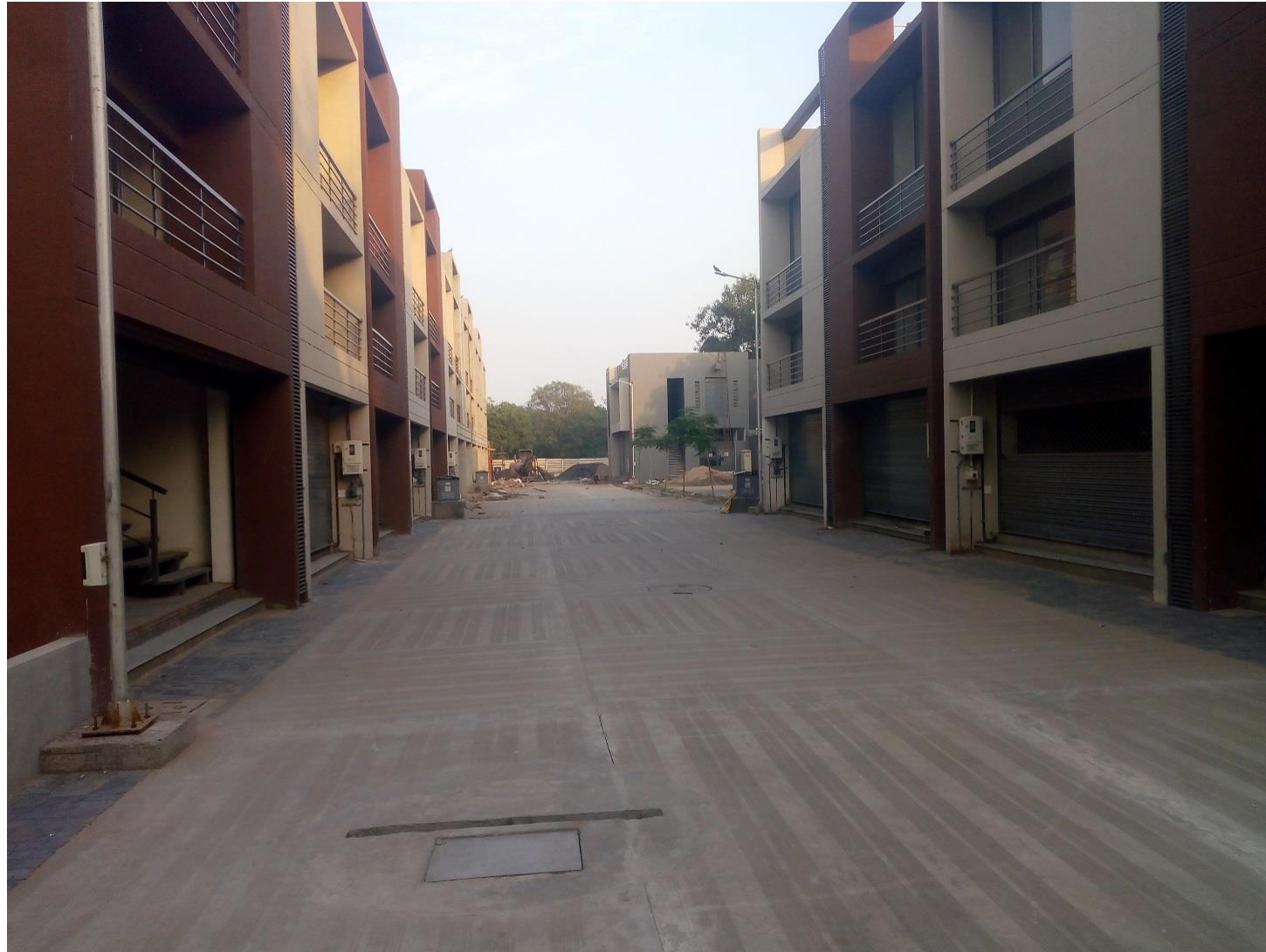
Actual Site Images – Shed Construction
