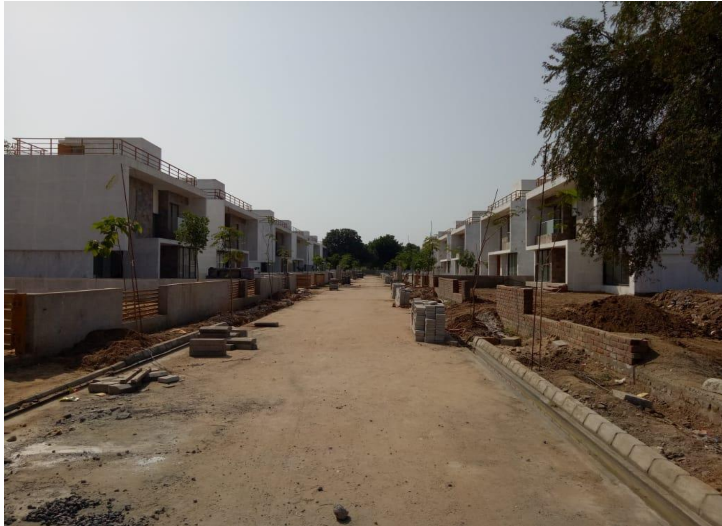
Actual Villa Construction
