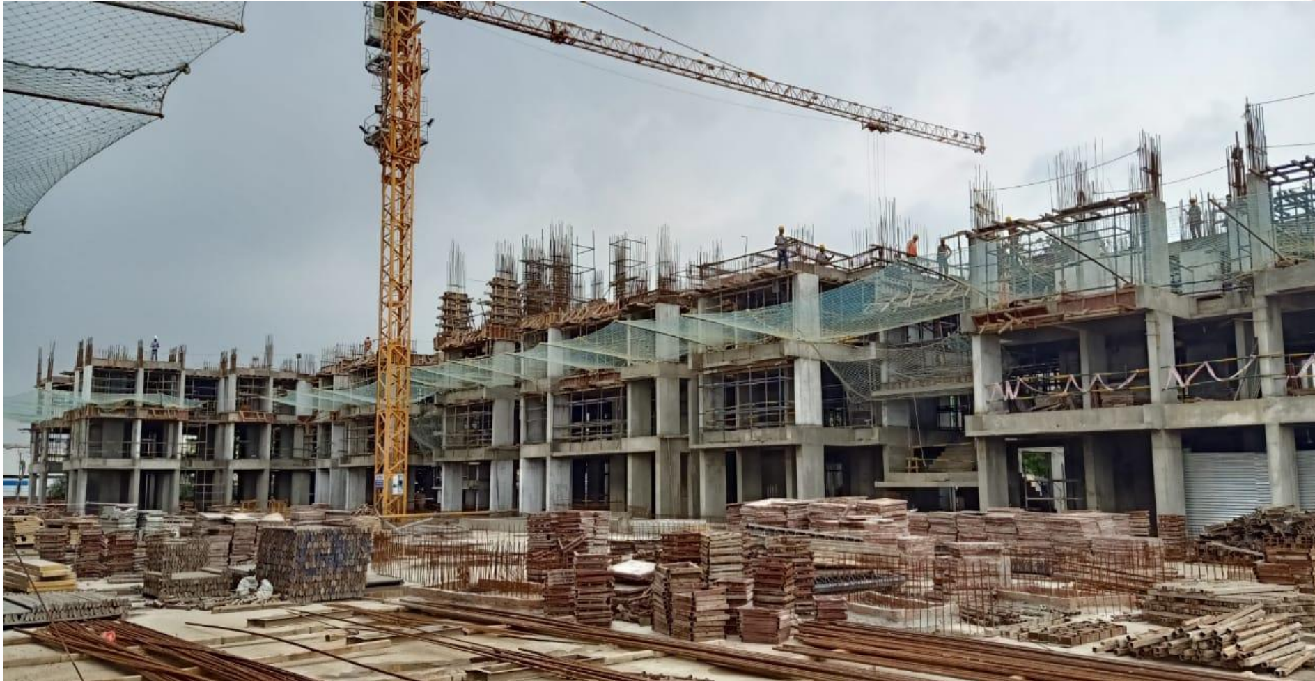
Actual Construction Image
