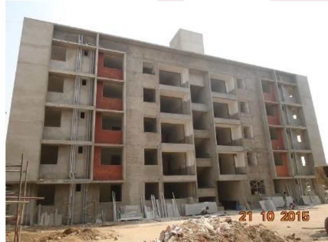
Block C Actual Construction
