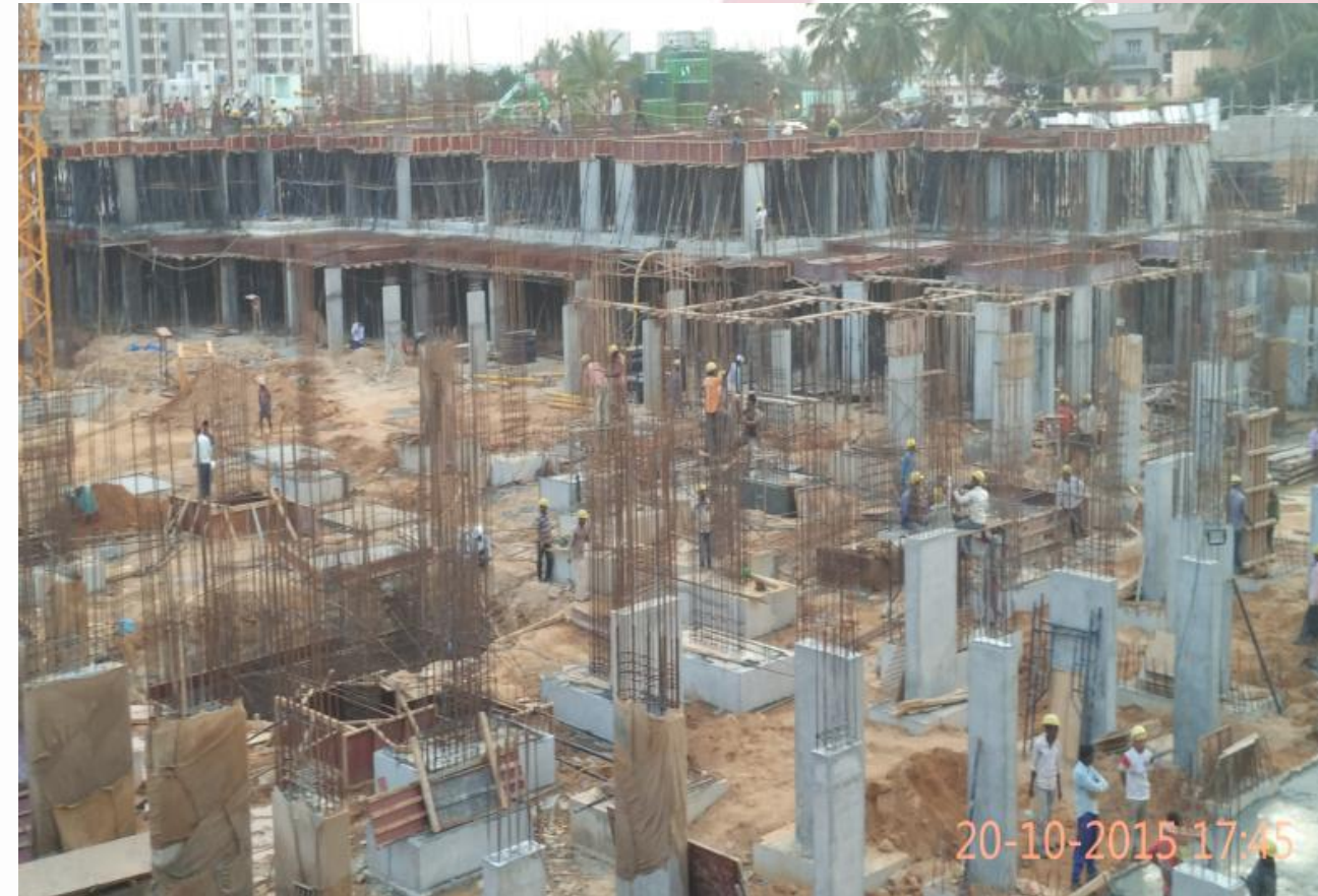
Block G – Actual Construction
