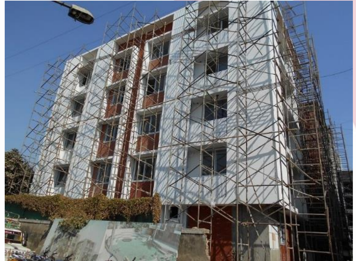
Block A Actual Construction
